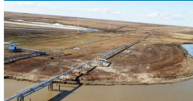
Наземная прокладка нефтепроводов
